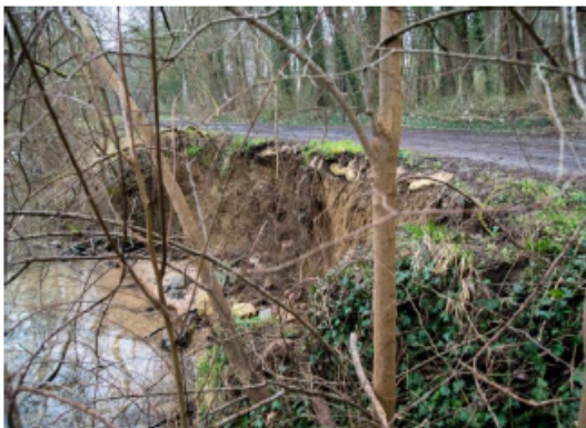
Constats d'érosion des berges de Seine au point F (SIARCE)
