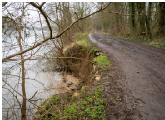
Constats d'érosion des berges de Seine au point F (SIARCE)
